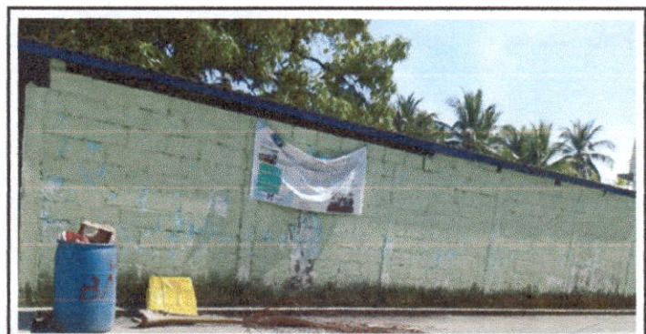
Foto 12 Repello de muro
