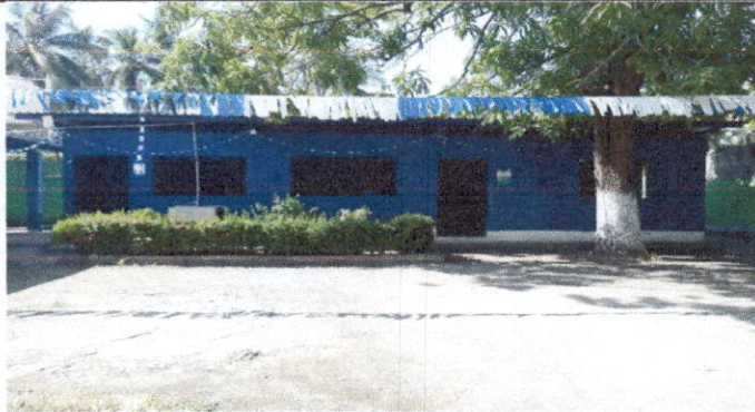
Foto 7 Sustitución de piso de tierra por torta de concreto
