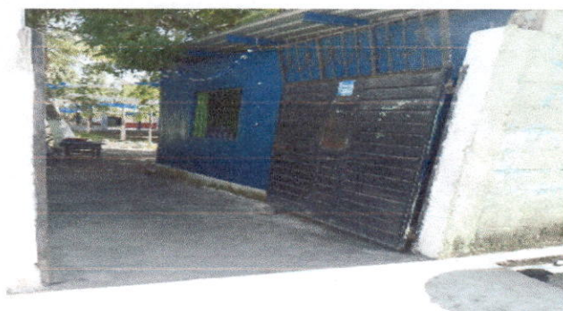
Foto 4: Sustrucción de portón
